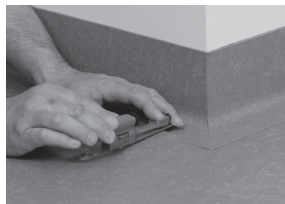
Skær gulvbelægningen, der skal lægges på fodpanelerne, ud.
