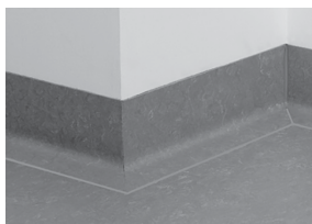
Arbejdet er færdigt
